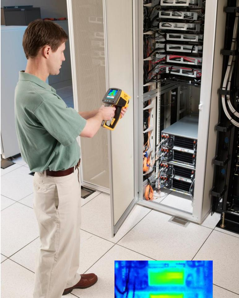
使用 Ti20 扫描刀片服务器背板的散热。
