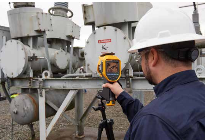
Figure 1. Un inspecteur utilise le détecteur de gaz SF 6 Fluke Ti450 pour inspecter des raccords vissés.
