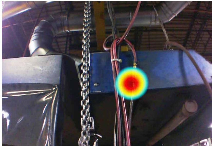
Kuvat on otettu ii900- vuotoäänen paikannuskameralla teollisuusympäristössä.
