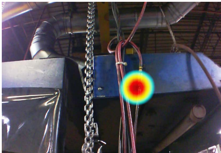
Immagini acquisite con telecamera acustica industriale ii900 in un ambiente industriale.
