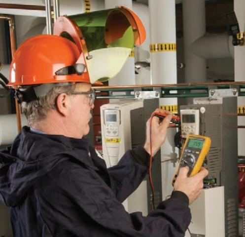
Jim Murphy, contramestre eletricista, usa o DMM Fluke 179 para examinar os sinais de baixa tensão no VFD recentemente instalado no sistema a vapor com mais de 40 anos de idade.
