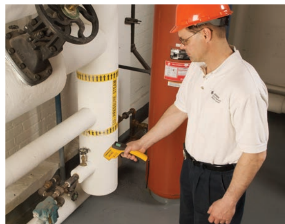
Darryl Dylla, gerente de HVAC/Casa de força, usa um termômetro infravermelho Fluke 62 para verificar coletores de vapor em todo o sistema de HVAC.
