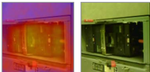
Normal driftstemperatur på driftskritisk bryter
