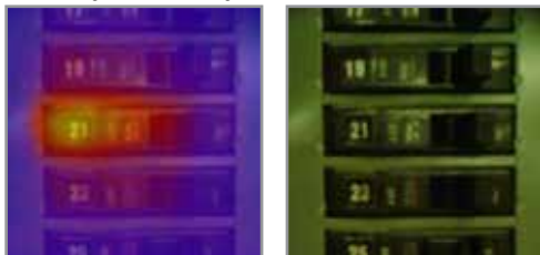
Przeciążone rozłączniki
