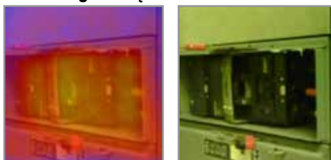
Normalna temperatura eksploatacji kluczowego rozłącznika
