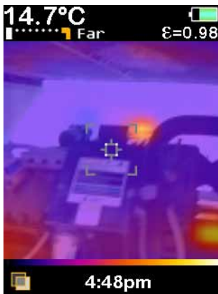
Compresseur à deux étages
