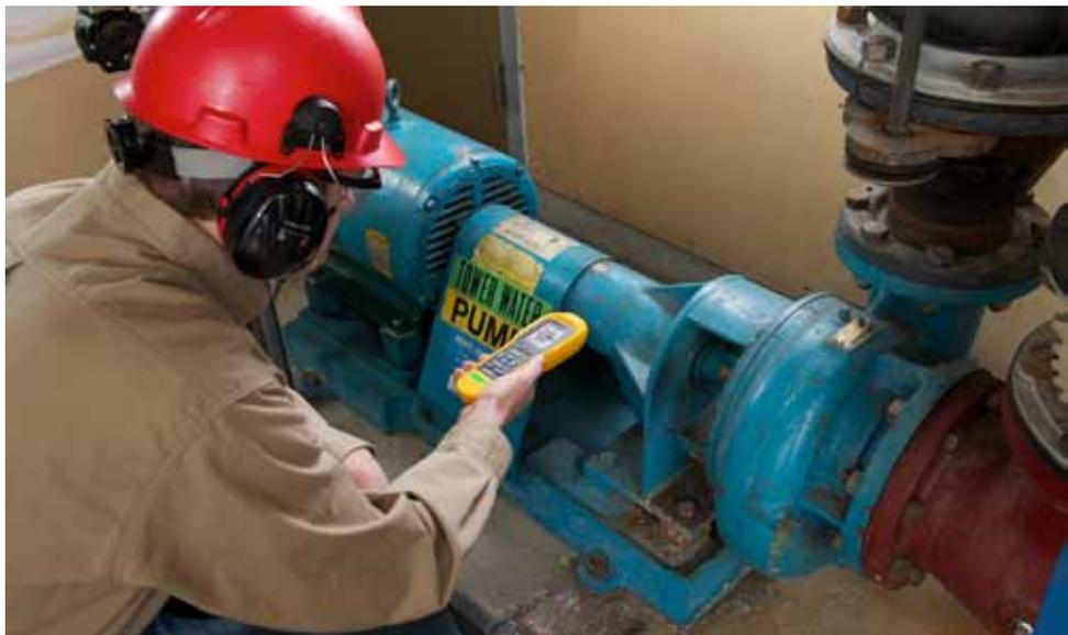
el innovador algoritmo Crest Factor Plus patentado por Fluke y una escala de gravedad intuitiva de cuatro niveles que identifica el estado del rodamiento como Bueno, Satisfactorio, Insatisfactorio o Inaceptable.
