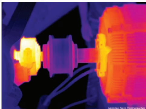
1. Identifique un posible problema con la cámara infrarroja Fluke.
