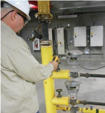
Dampf­temperatur am Eingang des Befeuchterventils messen
