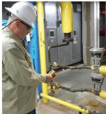
Prüfung des Kondensatabscheidungers, ob er im geöffneten Zustand ausgefallen ist und Dampf unkontrolliert austritt.
