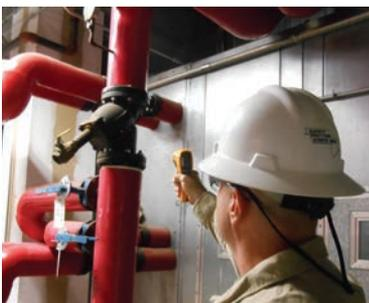
Wassertemperatur am Eingang zum Wärmetauscher der Luftaufbereitung prüfen
