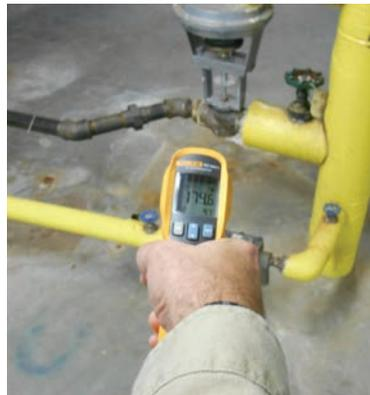
Überprüfung der Temperatur an der Kondenswasserleitung eines Kondensatabscheidungers auf ordnungsgemäße Funktion.
