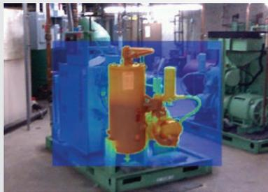
**AutoBlend™-Modus:** Aus einem teiltransparenten Wärmebild und einem Sichtbild entsteht durch Überlagerung ein einziges Bild, auf dem Sie das Problem leicht erkennen können.
