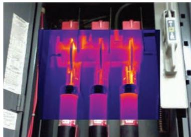
Bei Schalttafeln erleichtert der Bild-in-Bild-Modus die Lokalisierung heißer Stellen im Verhältnis zu Schaltschranktüren oder anderen Teilen der Schalttafel.
