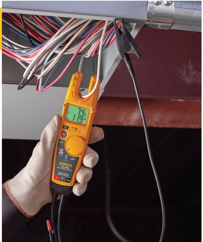
E já que a medição é efetuada através do isolamento do cabo, vai reduzir a exposição aos condutores metálicos. Também reduz o potencial para erros ou de entrar em contacto com o condutor errado.
