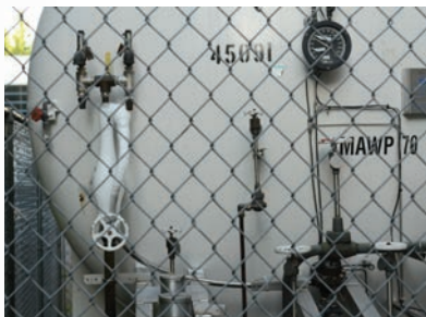
Sitios de inspección complicados, múltiples capas de componentes
