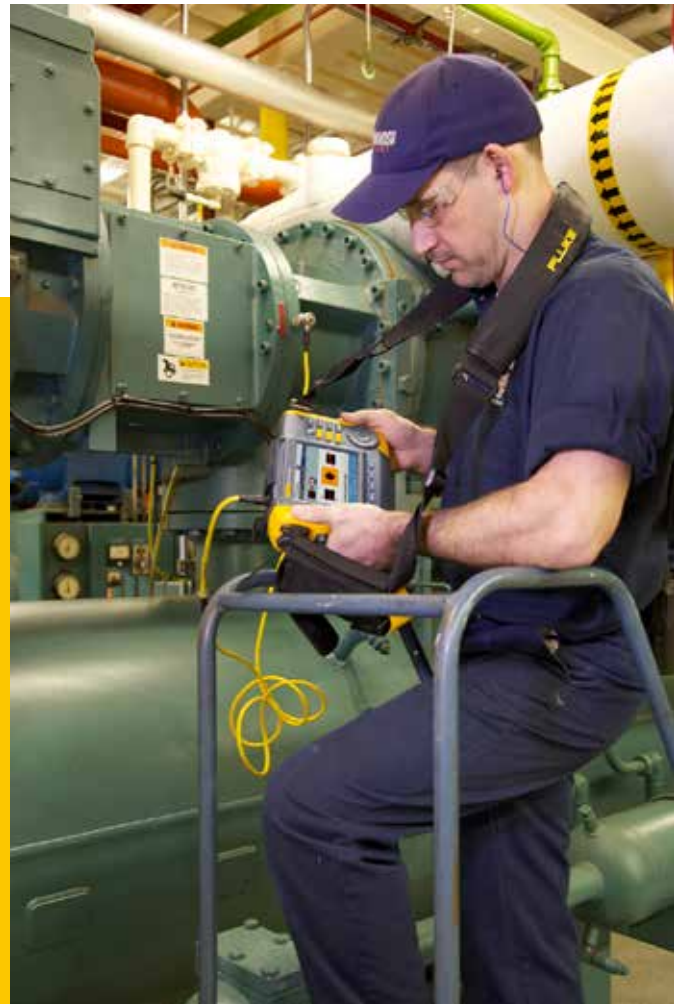
En Alpenrose Dairy, el análisis de vibraciones periódico proporciona datos para análisis de tendencias en un entorno de mantenimiento proactivo.
