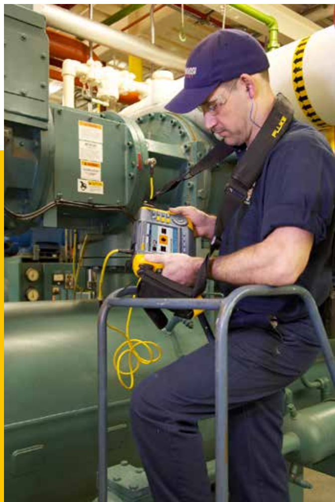
L'analyse des vibrations régulière à la laiterie Alpenrose fournit des données pour l'analyse des tendances utilisée en maintenance préventive.
