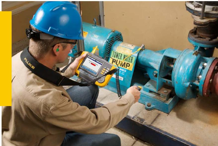
Conoscere l'analisi delle vibrazioni può cambiare un sistema "run to failure" in un programma di manutenzione proattivo basato sulle condizioni.
