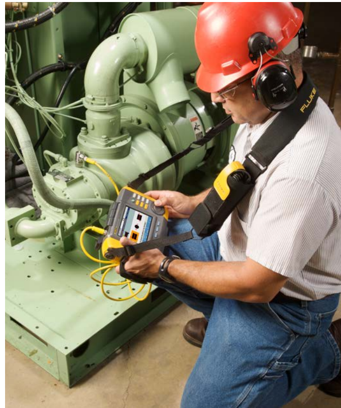
Diagnosticare i guasti più comuni con il tester di vibrazioni Fluke 810.
