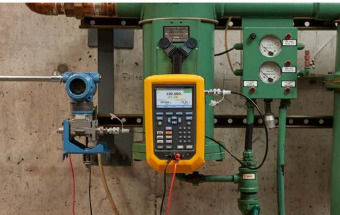
“729 압력 교정기의 자동 펌프는 핸드 펌프 사용으로 인한 계측 기기 오류를 줄이는 한편 교정 시간을 최대 40% 단축합니다.”
