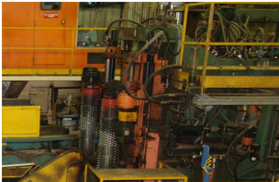
Przyrządy termowizyjne firmy Fluke są powszechnie wykorzystywane do konserwacji zapobiegawczej w środowiskach przemysłowych, takich jak firma Weyerhaeuser w Drayton Valley (Alberta).
