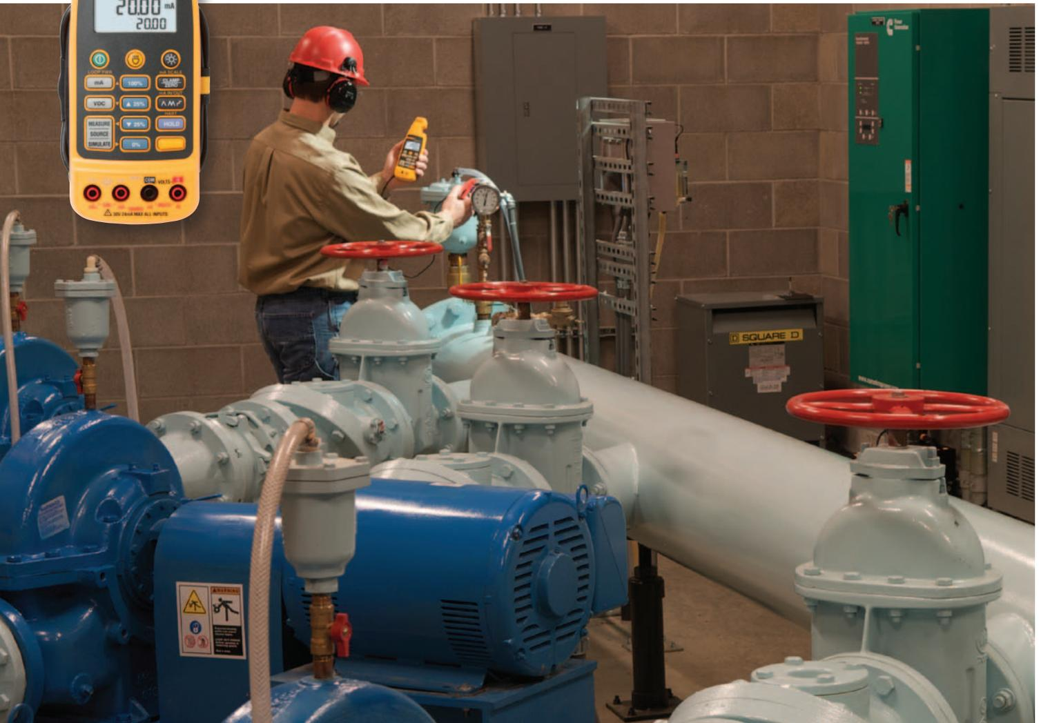
El primer paso consiste en medir la señal de 4-20 mA, ya sea interrumpiendo el lazo conectándolo en serie con un multímetro digital o utilizando una pinza amperimétrica de mA, como el Fluke 771, y verificando el valor de la corriente de lazo. Si la medición de la corriente de lazo no es la esperada, existen tres posibles motivos: los cables se han roto, se han desconectado o han entrado en cortocircuito, la alimentación eléctrica tiene un lazo defectuoso o la instrumentación está averiada.
