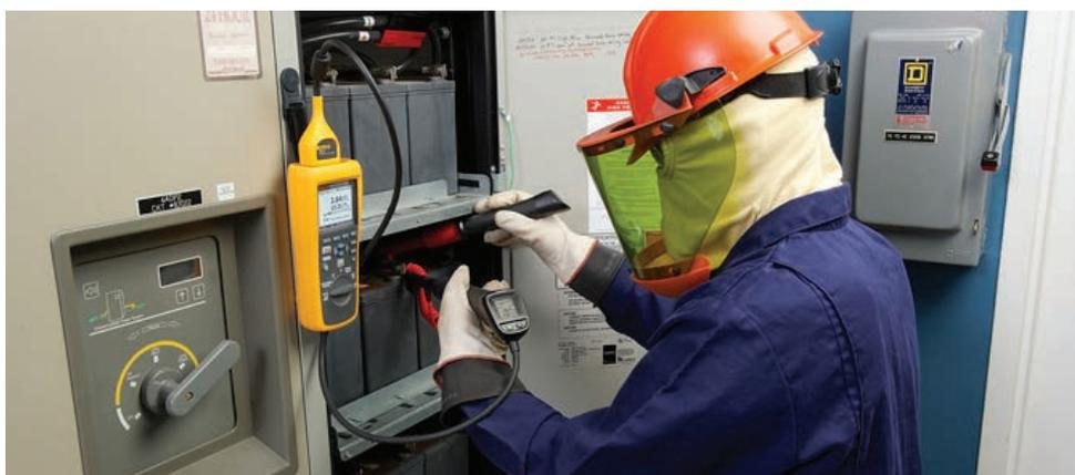
Menggunakan Fluke BT52X untuk mengukur impedansi, untuk uji nilai ohmic internal sel/unit triwulanan.
