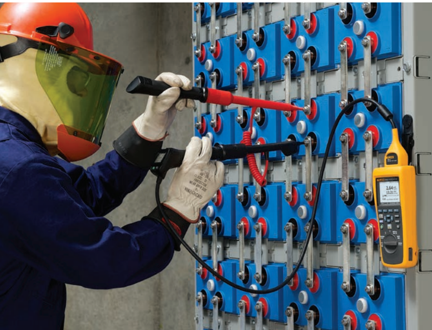
Mengukur nilai ohmic pada mode urutan
