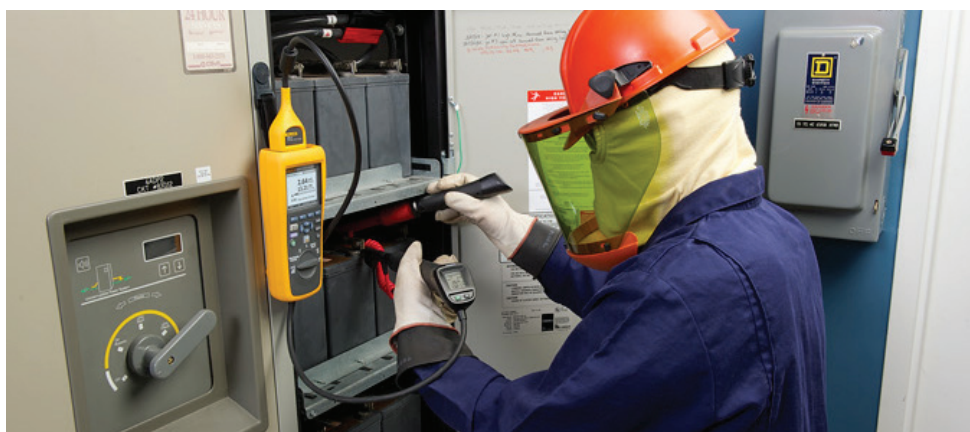
Использование Fluke BT52X для измерения сопротивления при ежеквартальном испытании внутреннего омического значения элемента/блока.
