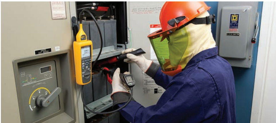
Üç aylık hücre/birim dahili ohm değeri testi için Fluke BT52X ile empedans ölçümü.
