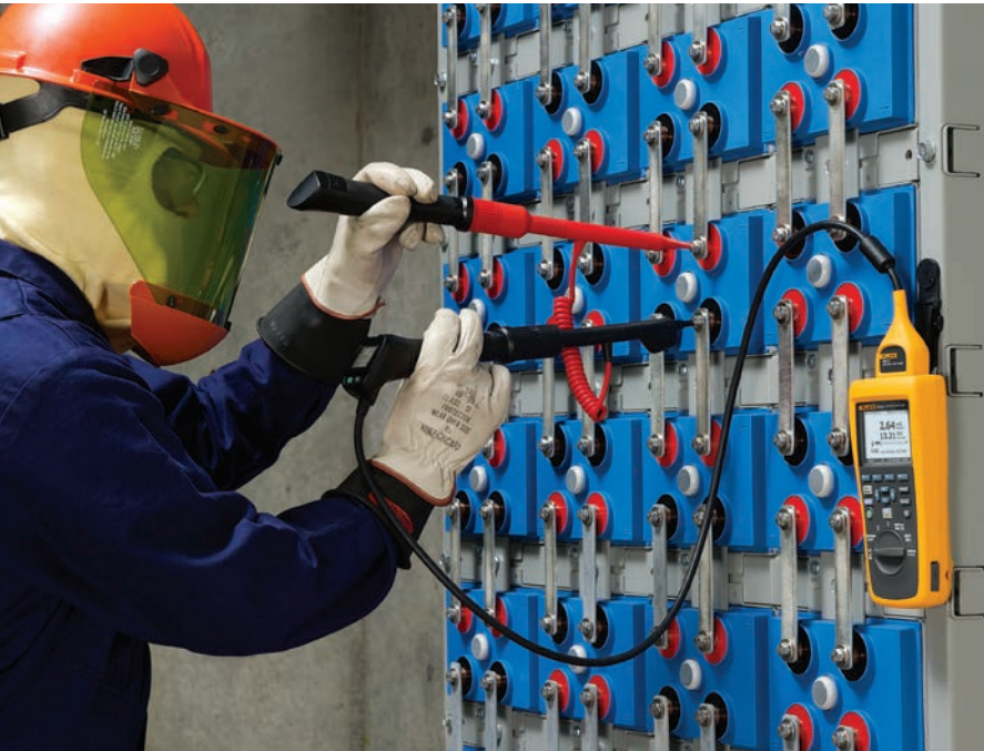
Dizi modunda ohm değerlerinin ölçümü
