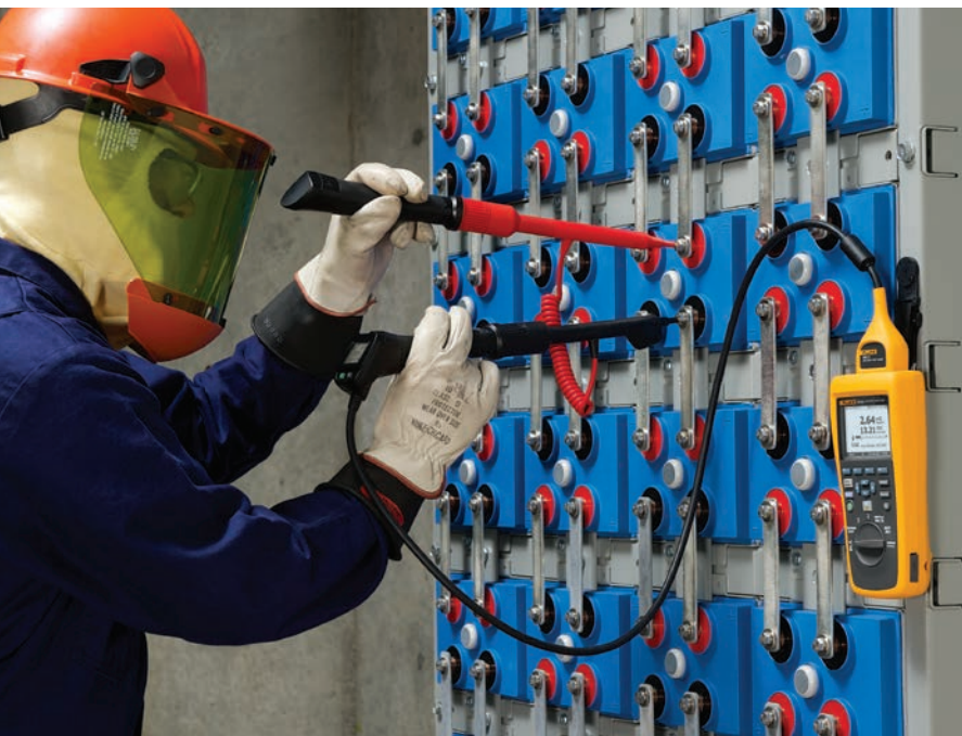
Måling av ohmske verdier i sekvensmodus
