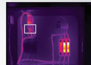
Image complète prise à une distance de 1,5 m avec une caméra infrarouge TiX1000. La zone affichée dans le cadre blanc est agrandie ci-dessous.
