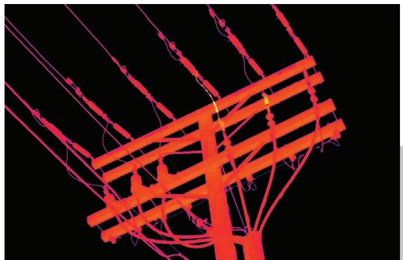
Stromversorgungsleitungen eines Energieversorgungsunternehmens
