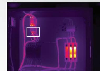
Imagem completa, capturada a 5 pés de distância, com um termovisor TiX1000. A área exibida na caixa branca está expandida abaixo.
