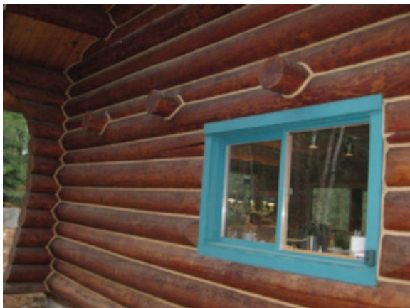
Abbildung 8: Blockhaus nach der Versiegelung und Abdichtung.
