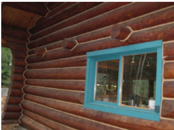
Figura 8. Casa de madera después del sellado y el calafateado.
