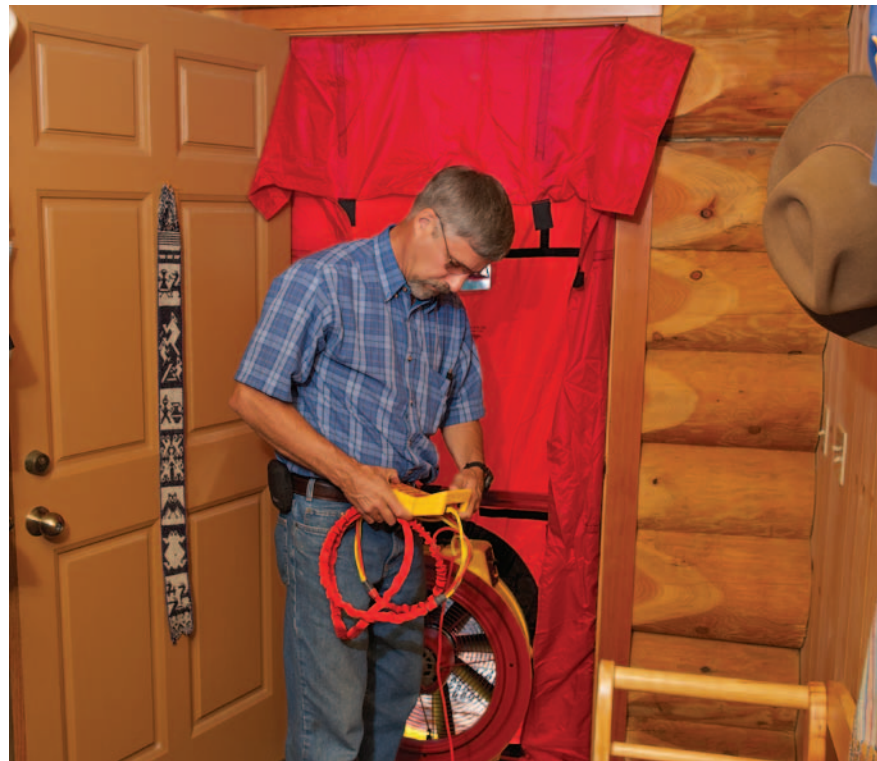
Figura 6. Fissaggio di una blower door.
