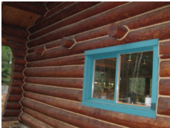
Figura 8. Casa in legno dopo essere stata isolata e coibentata.
