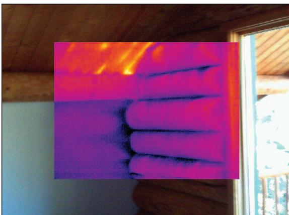
Figure 4. L'air froid (bleu foncé et noir) s'infiltrant entre les rondins de la paroi.
