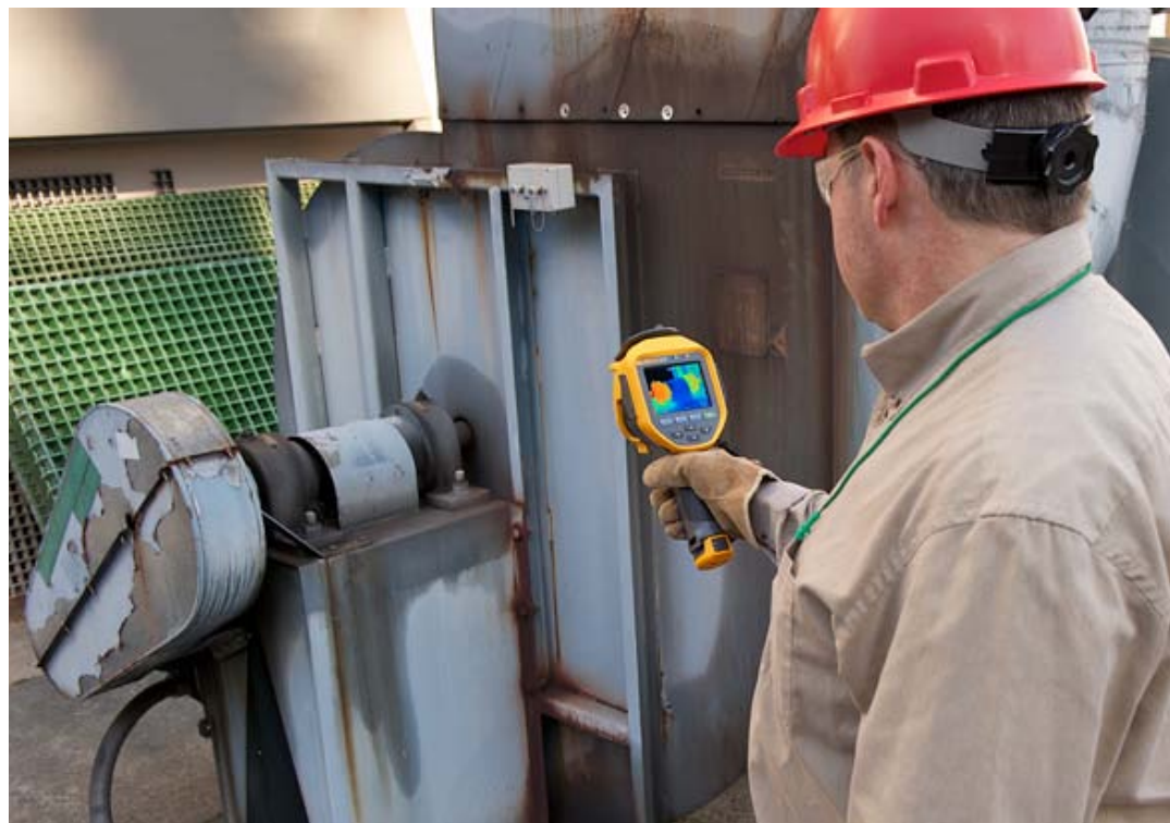
Puede ser complicado medir en ejes de acero inoxidable brillante con una cámara termográfica. Realice una compensación con una medición cerca del acoplamiento.
