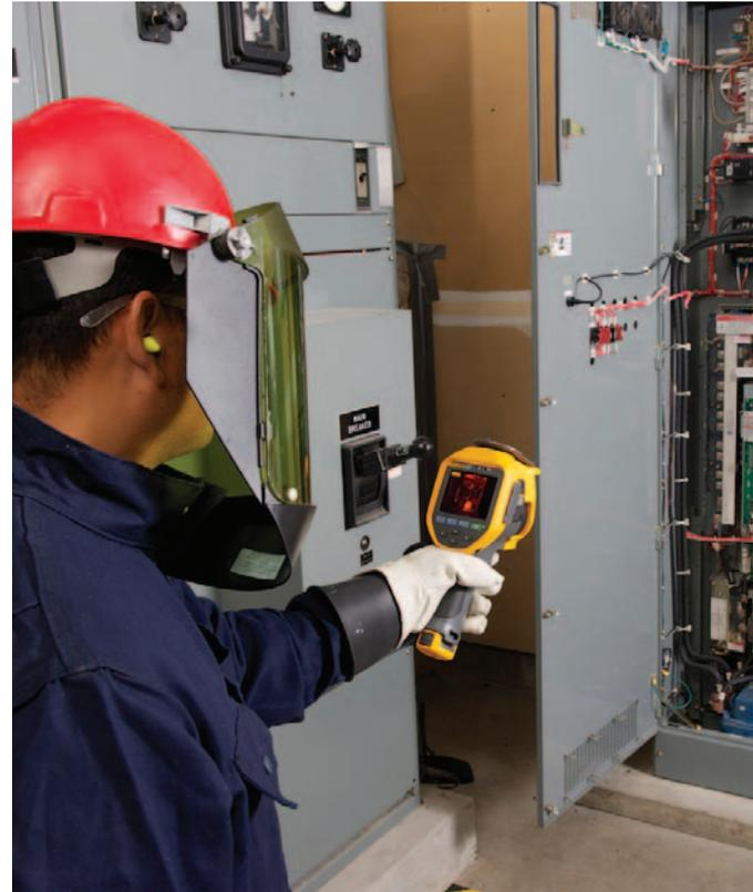
Quando si esegue l'analisi di un quadro elettrico alimentato, indossare dispositivi di protezione personale 70E per archi elettrici e tenersi ad una distanza di almeno un metro.
