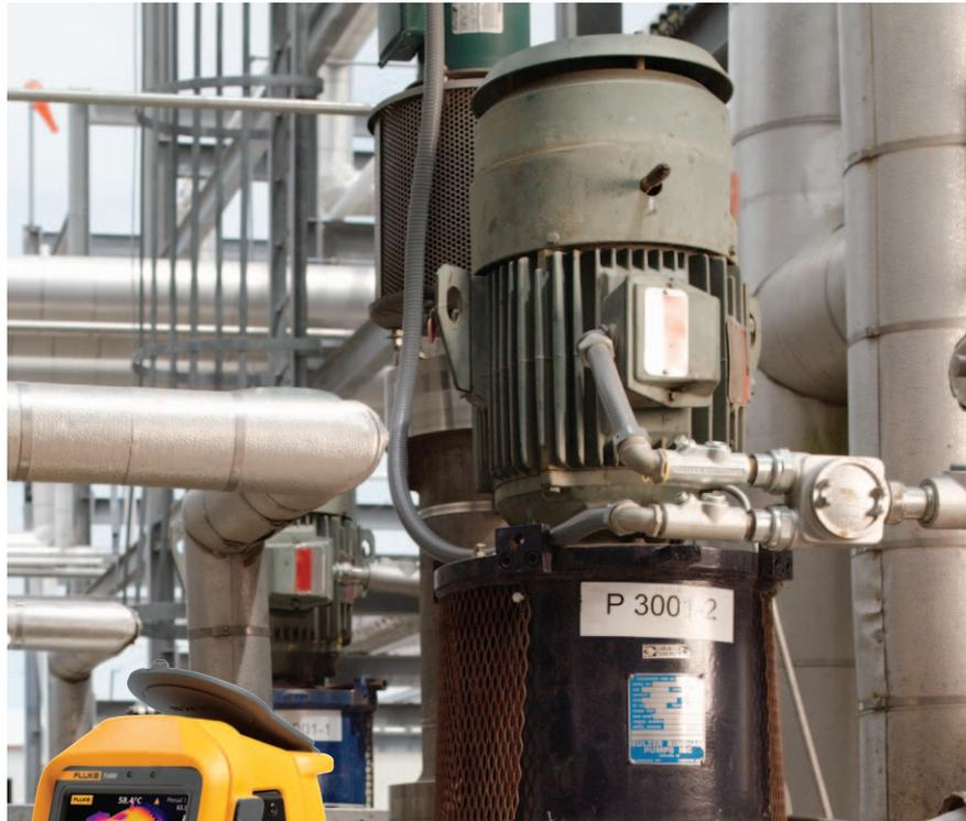
Mediante la utilización de termografías, Alltech dedujo que un caudal de aire y refrigeración insuficiente estaba provocando un mal funcionamiento de la junta de la bomba, ahorrando así un proyecto de 100.000 dólares por el fallo continuo de la junta.
