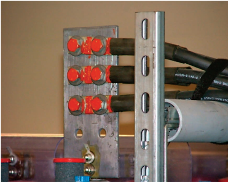
Semplici contrassegni dipinti come questi sono spesso usati per gli "obiettivi" ad alta emissività che aumentano notevolmente l'affidabilità dei dati radiometrici.
