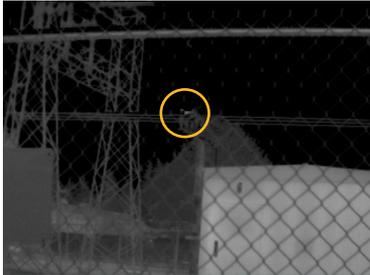
Figure 4. L'inspection extérieure de l'équipement extérieur d'un poste électrique avec une caméra thermique TiX560 et un objectif standard a permis de capturer une anomalie sur un des inverseurs de phase.
