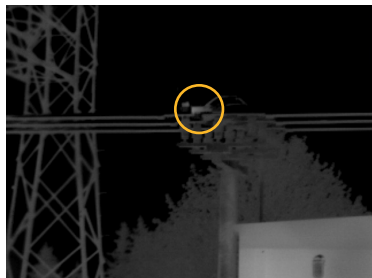
Figura 5: Analisar a mesma área com uma lente de telefoto 2x da Fluke mostra um ponto de calor na chave.
