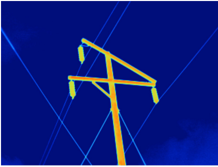
Figura 7: Poste de energia de alta tensão, capturado com uma câmera TiX560 e lente padrão.
