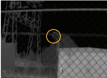
Abbildung 4: Bei der thermografischen Untersuchung der äußeren Betriebsmittel eines Umspannwerks mit einer Wärmebildkamera TiX560 und einem Standardobjektiv wurde an einem der Phasenschalter eine Anomalie erfasst.
