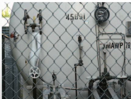
困難な検査現場
