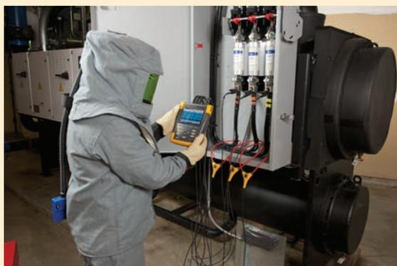
只需将电压测量导线和柔性电流探头连接至提供服务的电机即可。
