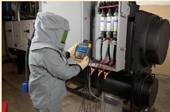
Cukup hubungkan kabel pengukuran tegangan dan probe arus fleksibel ke fasilitas yang memasok motor.
