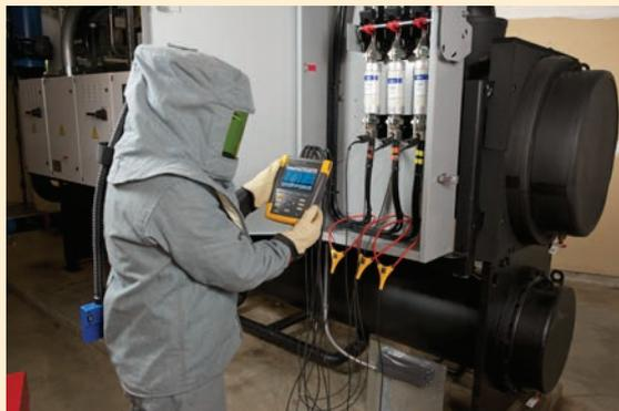
モーターを駆動する動力部に電圧測定リードとフレキシブルな電流プローブを接続するだけでセットアップは完了です。
