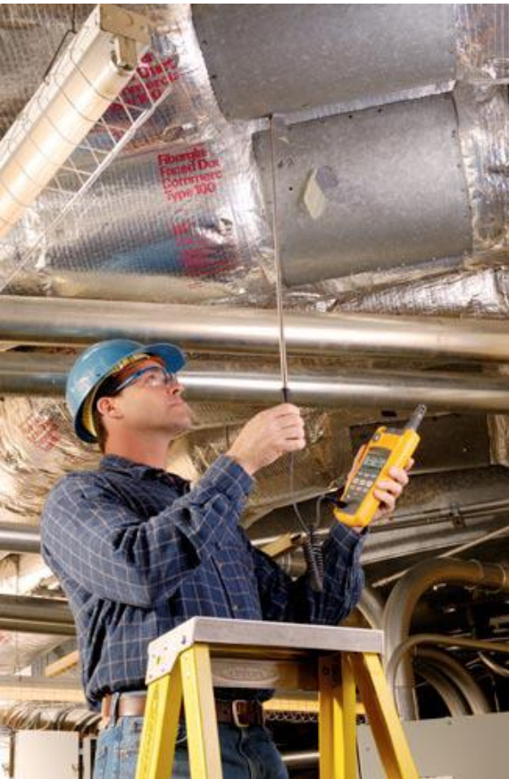
测量风管内的风速
