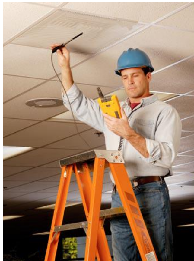
测量供风口的空气流量
