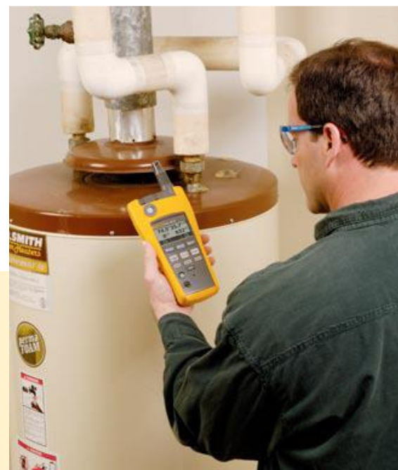
测量煤气热水器周围的一氧化碳
