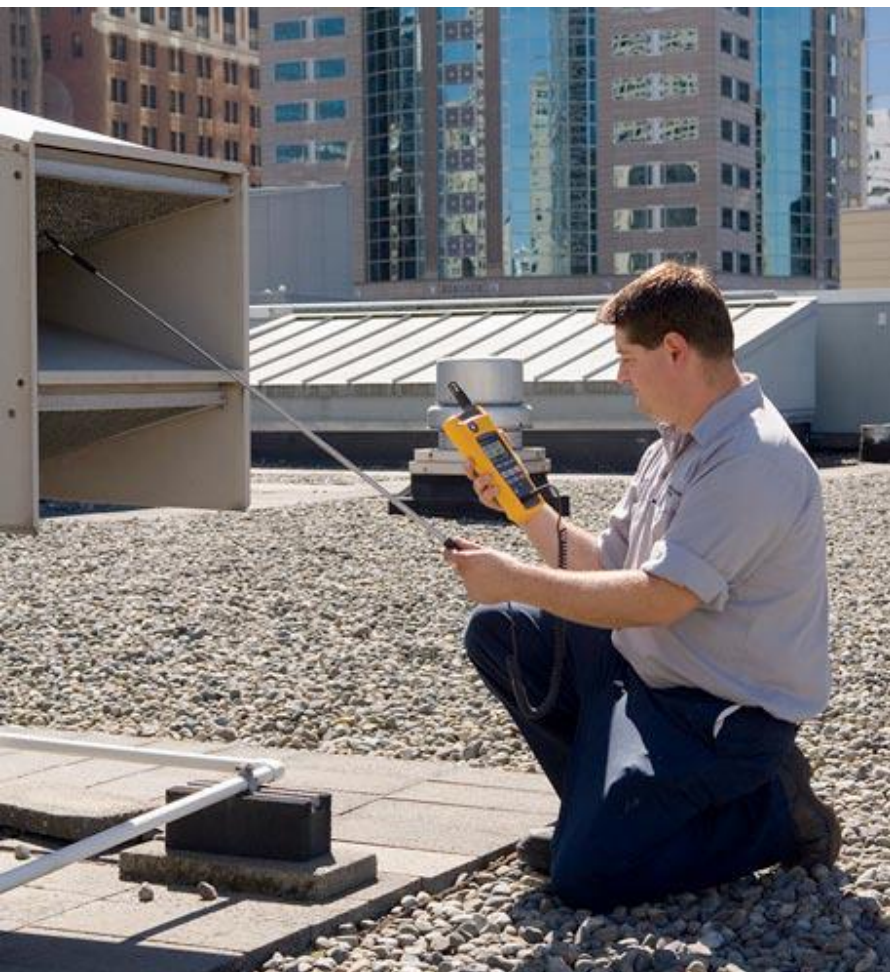
在进风口使用风速探头进行测量
